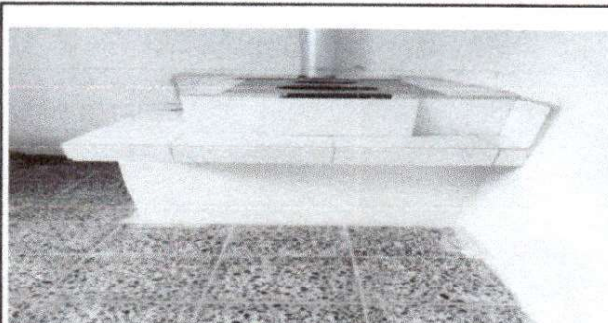
Foto 6: proceso de finalizacion de la estufa de concreto
