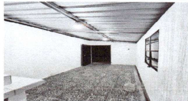
Foto 4: finalizacion de la instalacion del techo
