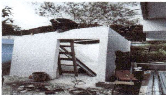
Foto 1: paredes de blok finalizadas con su respectivo repello
