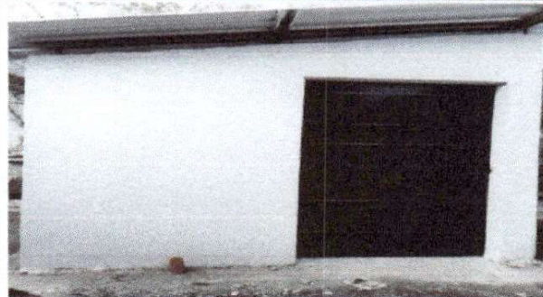
Foto 2: instalacion de puerta
